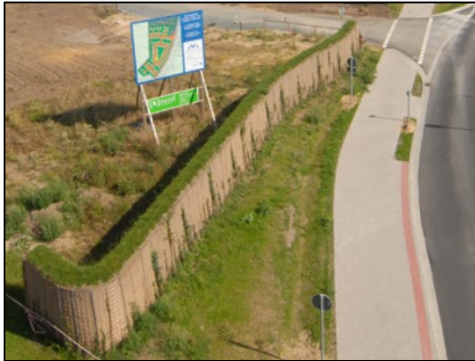
Abbildung 4: Beispielsystem KNL (Lärmschutzwall) beim Einbau (links) nach Vollbegrünung (rechts) 1
